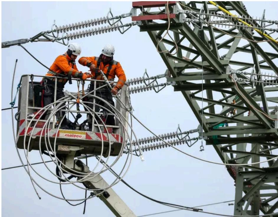
Monteure erneuern eine 110 KV Hochspannungsleitung des Stromnetzbetreibers Mitnetz.
